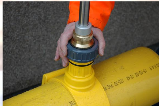
22. Plaats de stroomrichtingmeter in het opzetstuk en borg deze door de wartel geheel naar beneden te draaien
